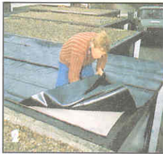
Корневая защитная пленка препятствует внедрению корней растений в крышу. Она свободно свисает, пока не будет закончена полная укладка кровли.
