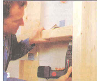
Для монтажа умывальника к стойкам каркаса стены на уголках и шурупах крепят прочный поперечный брус.
