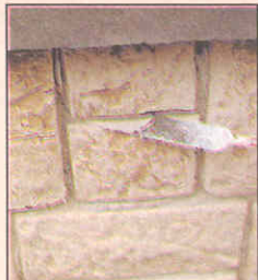
Излишки клея лучше удалять, когда он слегка подсохнет, чтобы не испачкать края камней.
