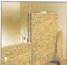
1 Саманными элементами заполняют каркас стены, возведенный из брусков квадратного сечения.
