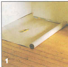
1 Старый дощатый пол укрывают плотной (упаковочной) бумагой, чтобы керамзит не просыпался на промежуточное перекрытие.
