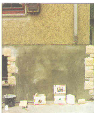
Здесь еще раз показано начало работы. Первые угловые камни совпадают по уровню, чтобы при последующей облицовке поверхности...
