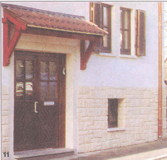
11 Такая облицовка из камня не только защищает цоколь от осадков и других атмосферных воздействий, но и придает дому неповторимый облик.
