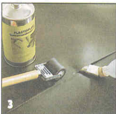
В качестве защитного холста можно использовать, например, прудовую пленку. Ее укладывают без складок. Полосы пленки склеивают друг с другом специальным клеем или сваривают.
