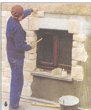
...чтобы создать впечатление, будто «камни кладки» наполовину опираются на уже возведенные боковые откосы.
