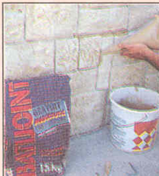
Раствор для расшивки швов удобно положить в прочный пластиковый пакет. Свертывающий пакет с тыльной стороны, раствор постепенно выдавливают в швы.
