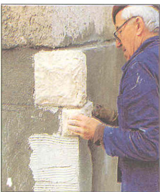
Второй угловой камень — меньшего формата. Его кладут, развернув на 180°. Как раз отсюда и начинается укладка камней с «неправильной» перевязкой швов.
