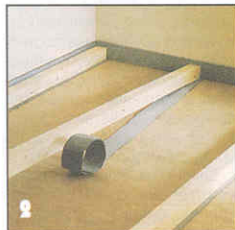
2 Лаги под новое напольное покрытие укладывают на войлочные полосы (или полосы из мягких ДВП).
