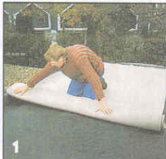
По старой кровле расстилают специальный защитный холст шириной 200 см, который защищает корневую систему растений.
