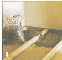
3 Между лагами отсыпают керамзит, препятствующий возникновению резонанса старого дощатого настила.
