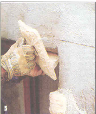
У перемычек по краям кладут большие угловые камни, горизонтальную полку которых обламывают сбоку,...
