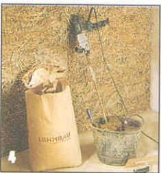
4 Стену из саманных элементов оштукатуривают раствором из разведенной в воде глины, нанося его слоем толщиной 2 см в два-четыре приема.
