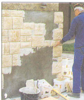
...ряды камней были бы ровными. Для этого требуется точный глазомер и чувство гармонии.
