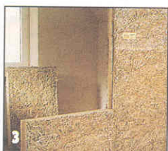
3 Каждый ряд элементов дополнительно усиливают вертикальным бруском, прикрепленным к полу и потолку. Так постепенно, сегмент за сегментом, возводят всю стену.
