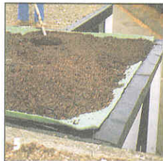
На подготовленную поверхность отсыпают и по возможности равномерно распределяют специальный почвенный субстрат. Чтобы не повредить пленку, садовыми инструментами следует работать осторожно.
