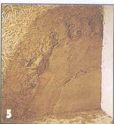
5 Сначала влажный глиняный раствор вытирают руками в саманную набивку. Затем наносят основной и отделочный слои.
