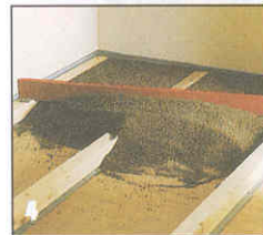
4 Керамзит разравнивают в секциях рейкой-правилом так, чтобы он был заподлицо с лагами. После этого по лагам настилают новые половые доски.
